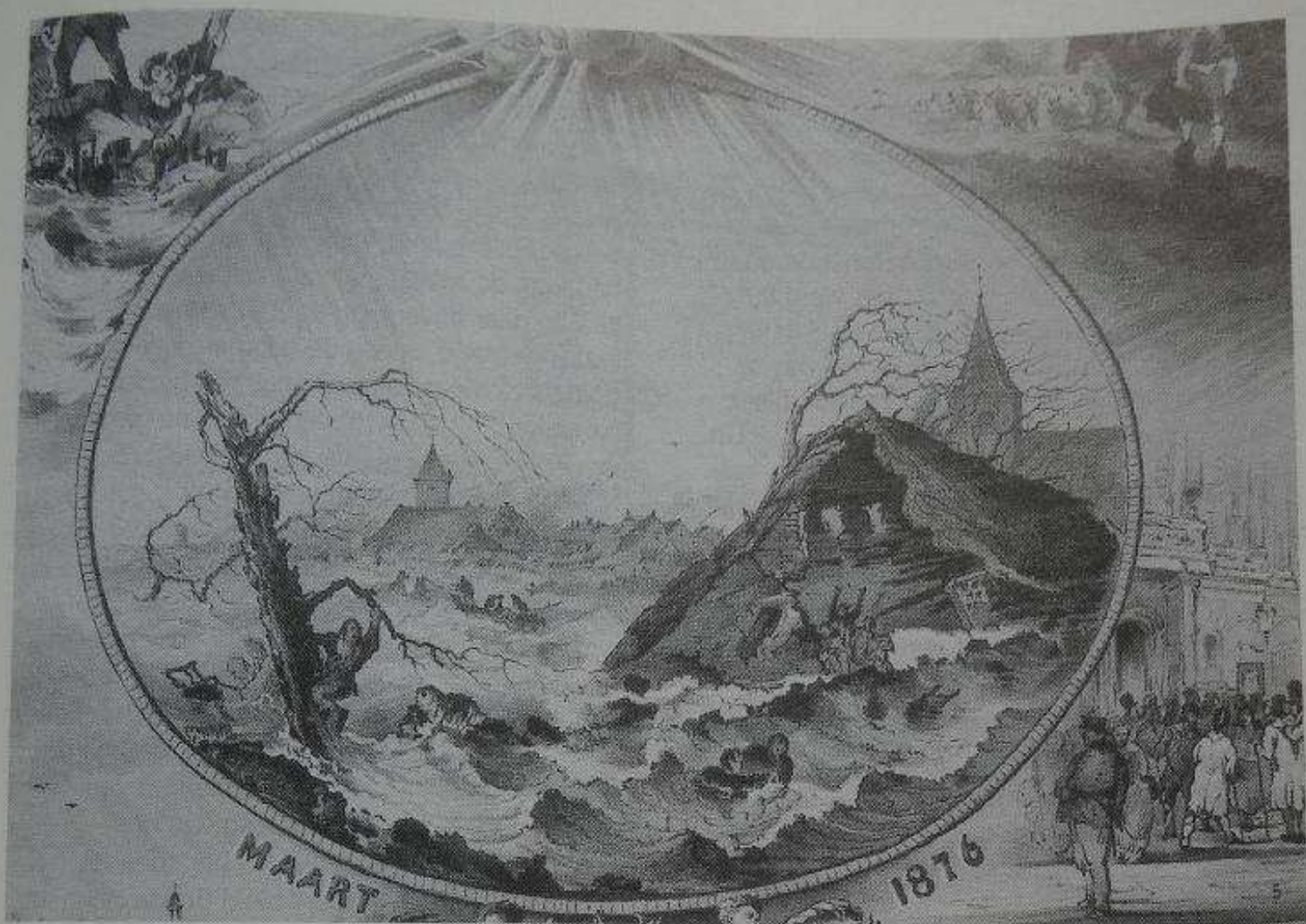
Detail van de gedenkplaat van de watersnoodramp in 1876, getekend door Jan Kuipers en uitgegeven door J.H. Knierum te Gorinchem, waarvan de opbrengst ten goede moest komen van de noodlijdenden, 1876. Omgeven door woeste golven proberen de bewoners van Poederoijen een goed heenkomen te vinden. (foto Streekarchief Bommelerwaard)
