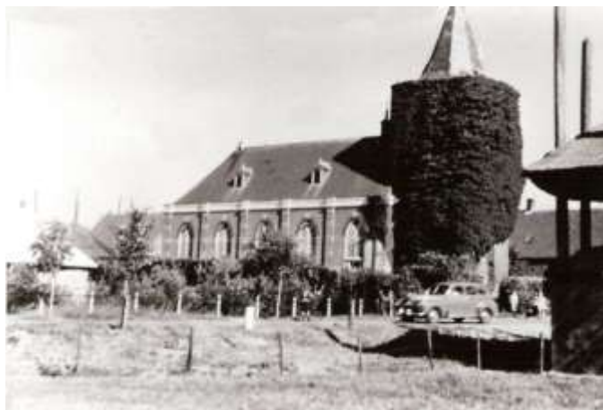
De toren begroeid met klimop voor de restauratie.
